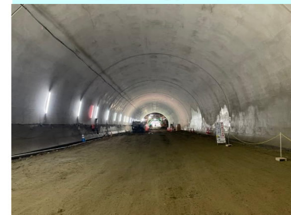
覆工コンクリート施工状況
