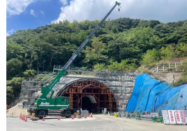
坑門工施工状況
