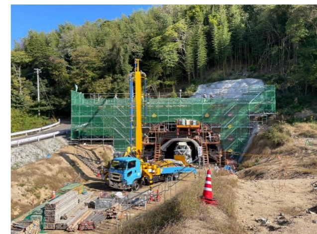
終点側(宇山)坑門工施工状況(打設)
