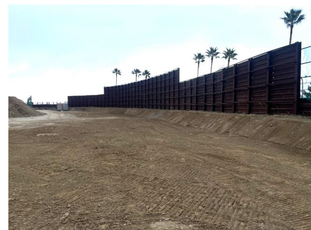
起点側（炬口）仮設備ヤード
