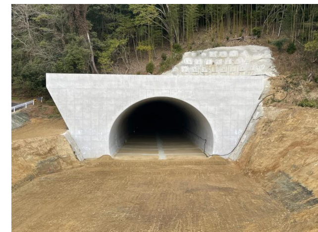
終点側（宇山）坑門
