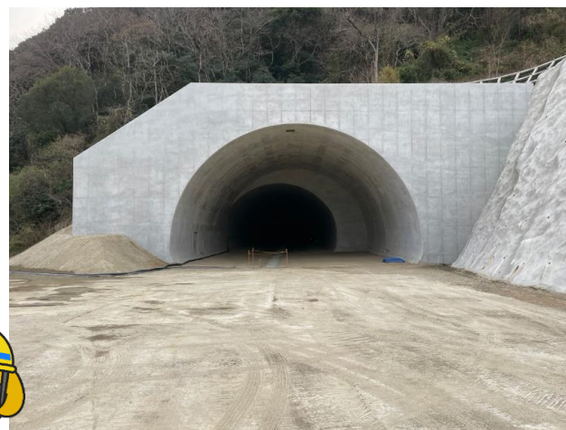
起点側（炬口側）坑門
