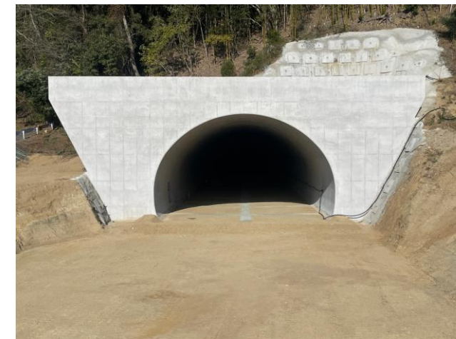
終点側（宇山側）坑門
