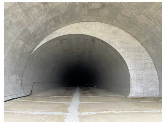
トンネル坑内
